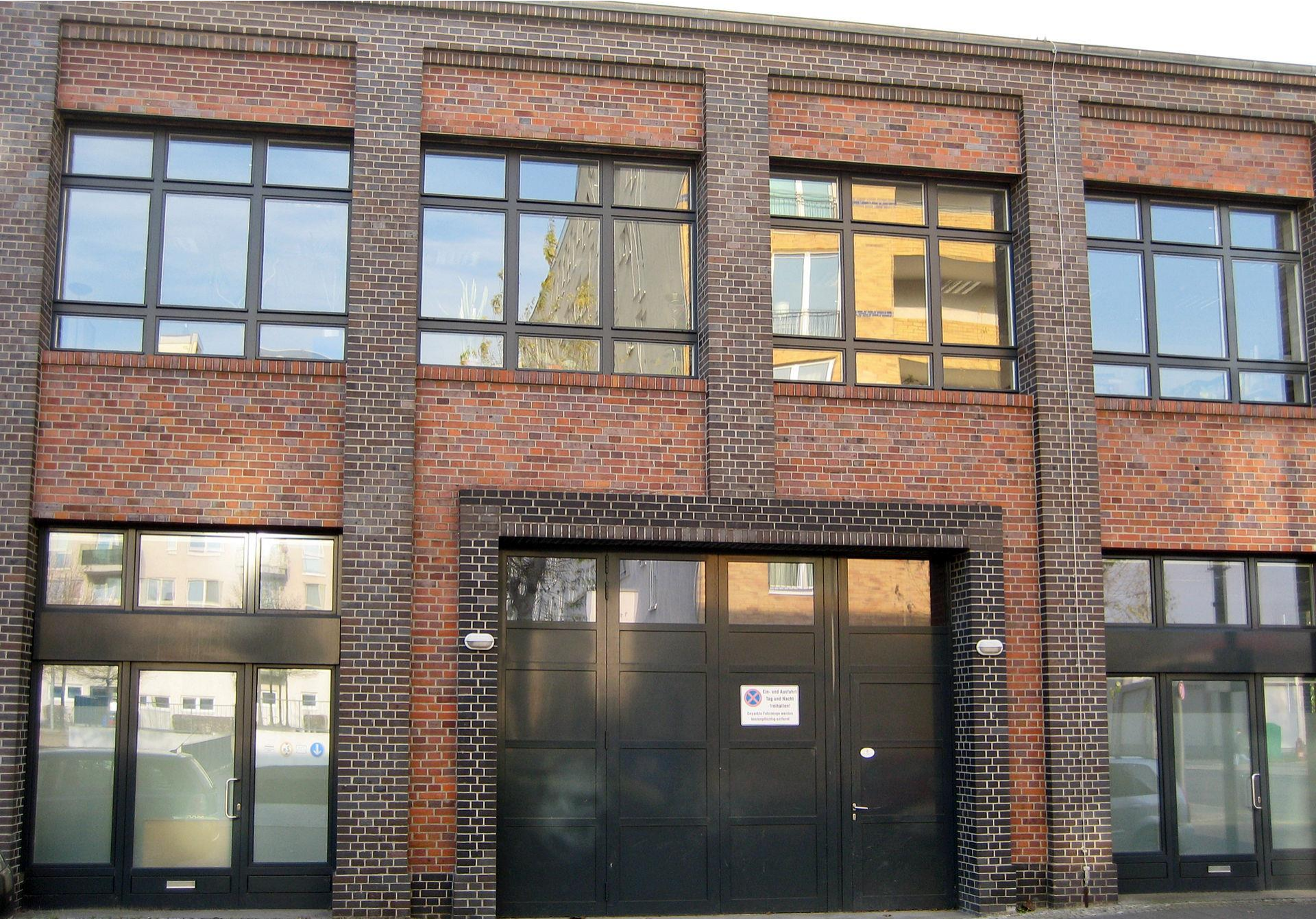
ehem. Kabelwerk Dr. Cassirer Nordseite
